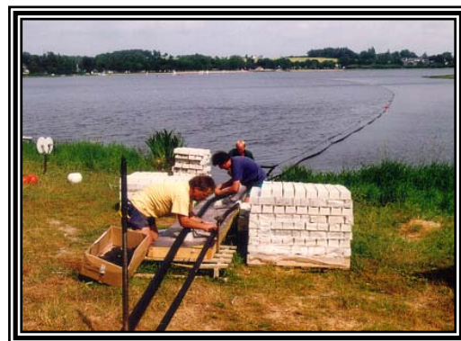
Mise en place des lignes de bullage
