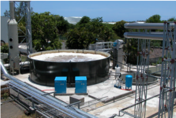
SICA DES SABLES, Equarrissage
